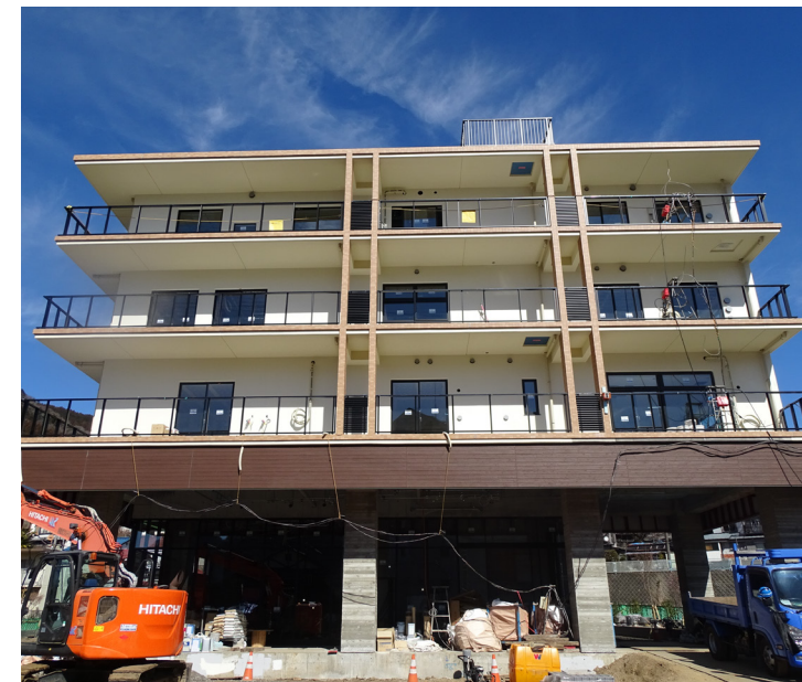
建設中の様子
