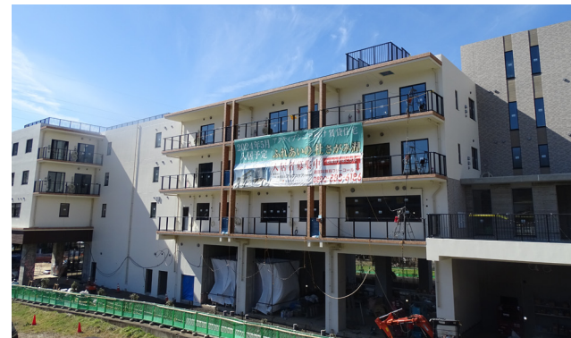
建設中の様子
