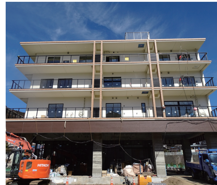
建設中の様子
