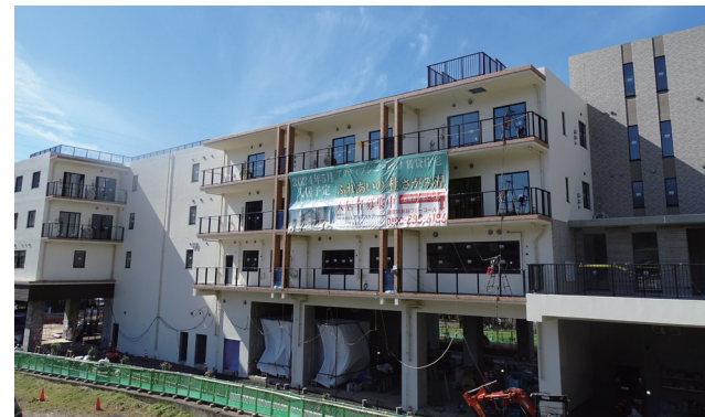
建設中の様子
